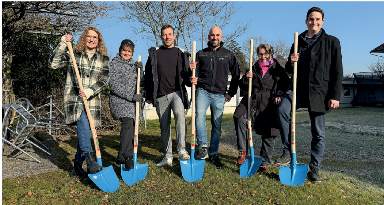
Beim Spatenstich (von links): Therese Greub (Leitung Bereich Personal, Mitglied Geschäftsleitung inklusia), Susan Mathis (Leitung Bereich geistige Beeinträchtigung, Mitglied Geschäftsleitung inklusia), Yanick und Simon Durrer (Durrer Gartenbau AG), Betty Ott-Lamatsch (Stiftungsratspräsidentin inklusia), Benedikt Lüchinger (Junge Wirtschaftskammer JCI, Präsident). Bild: Patrick Jordi
